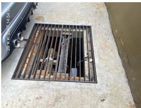
บ่อพักน้ำทิ้งสุดท้ายก่อนระบายออก
